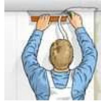
**4.** Enlever les excédents du plafond, des plinthes, des fenêtres etc. à l'aide d'une spatule en plastique et d'un cutter.
