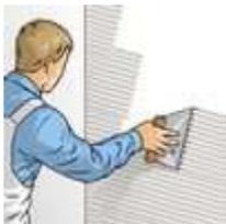
2b. Pour les supports moyennement et fortement structurés, appliquer le système de collage ERFURT SR 4 perpendiculairement au sens du revêtement à l'aide d'une spatule crantée, en utilisant suivant le support la dentelure B2 ou C3.
