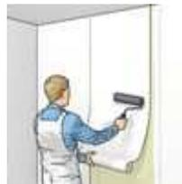
6. RENOMUR HP doit être tapissé après le séchage. En tapissant, décaler les joints latéralement pour éviter un encollage bord à bord.
