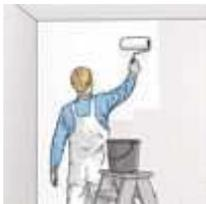
2a. Pour les supports lisses et ceux légèrement structurés, enduire les lés un par un à saturation avec le système de collage ERFURT SR 2 en utilisant un rouleau à longs poils.
