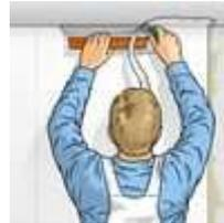
5. Enlever les excédents des plafonds, plinthes, fenêtres, etc. à l'aide d'un cutter et d'une spatule.
