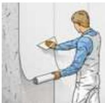
3. Appliquer le revêtement mural sur le système de collage ERFURT humide et coller bord à bord à joints vifs. Lisser avec une spatule en plastique.
